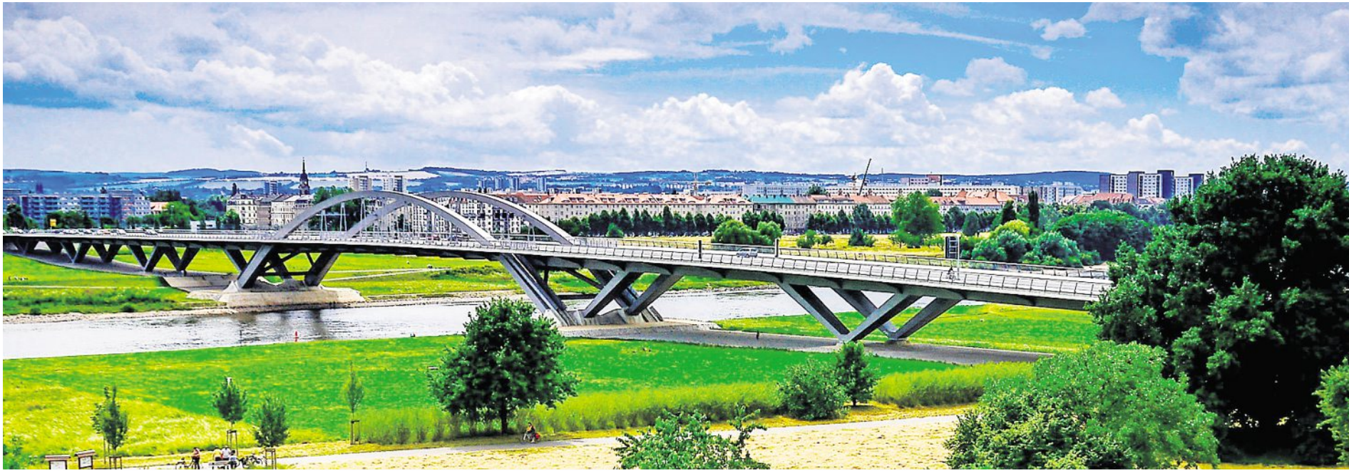
Ein Blick vom Waldschlößchen-Pavillon auf die Brücke. An diesem Sonntag ist das erste Jubiläum der Eröffnung. Neun Millionen Fahrzeuge sind schon darübergerollt. Fotos: Marco Klöpper (2)
